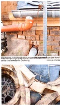
Die Mauern der Fenster werden per Hand restauriert, eine mühselige Arbeit.
